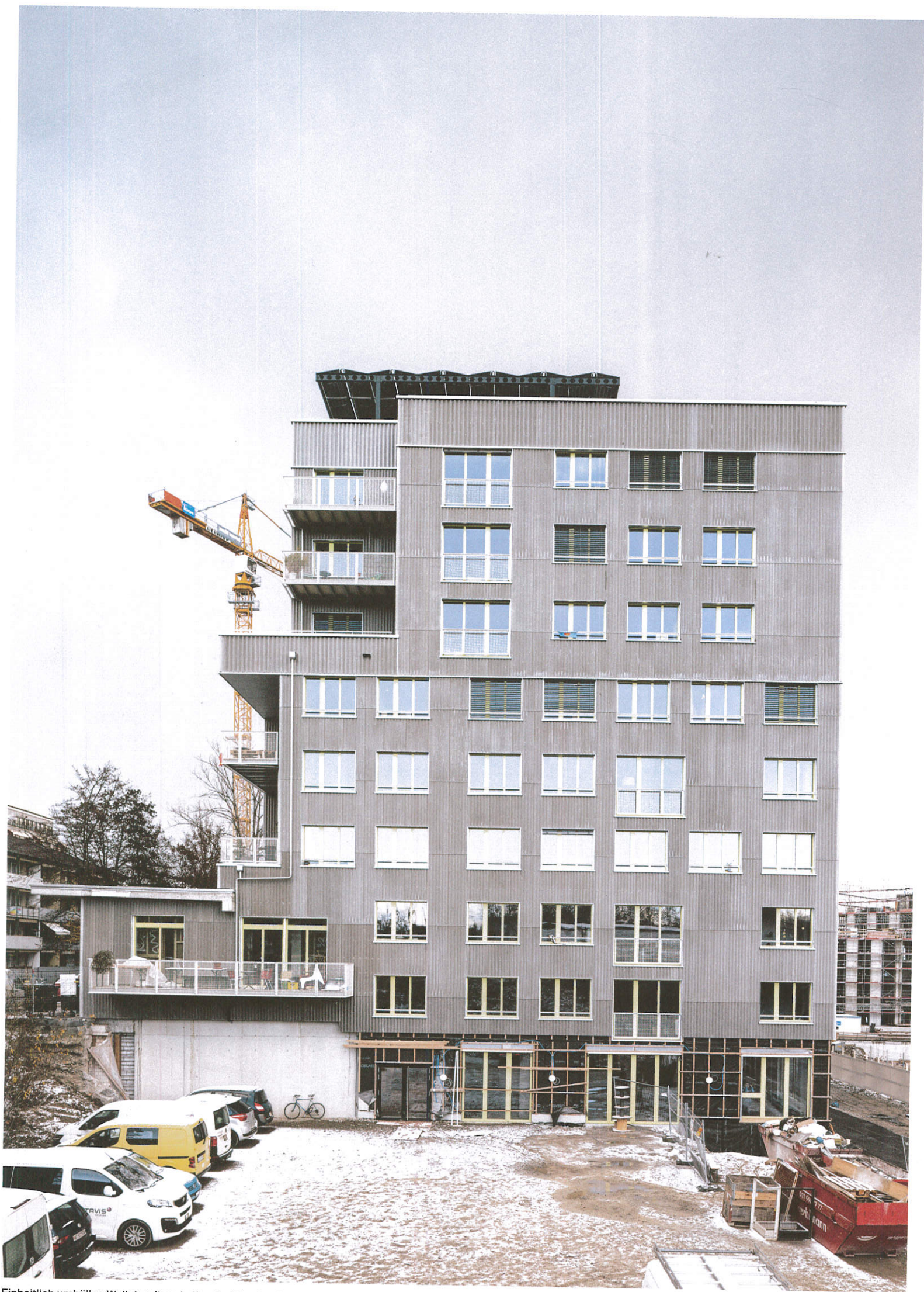
Einheitlich umhüllen Welleternit und giftgelbe Fenster den Bestand und die Aufstockung. Dahinter ein wahres Raumlabyrinth, zuoberst Solarpergola und Gemeinschaftsgarten.
